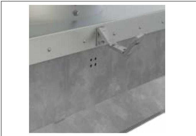
**ÉTAPE 4 :** Fixez l'attache à l'aide de vis sur la costière du toit.
